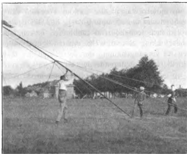
Opzetten van een 9-meter-mast.
