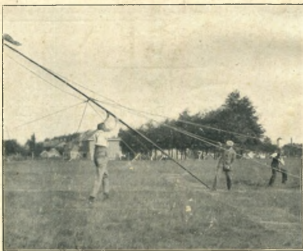
OPZETTEN VAN EEN 9 METER-MAST
